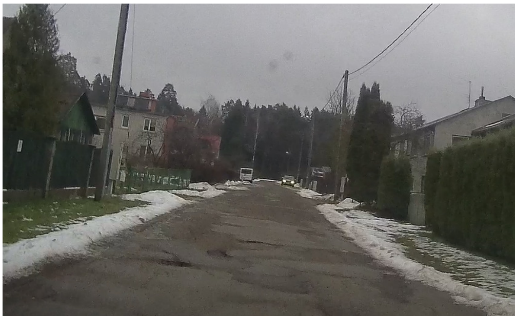
6.attēls. Skats uz trases beigām. Segumā izveidojušās bedres. Segumam nav nodrošināts pietiekams šķērskritums, tādējādi ir kavēta ūdens atvade no brauktuves.
