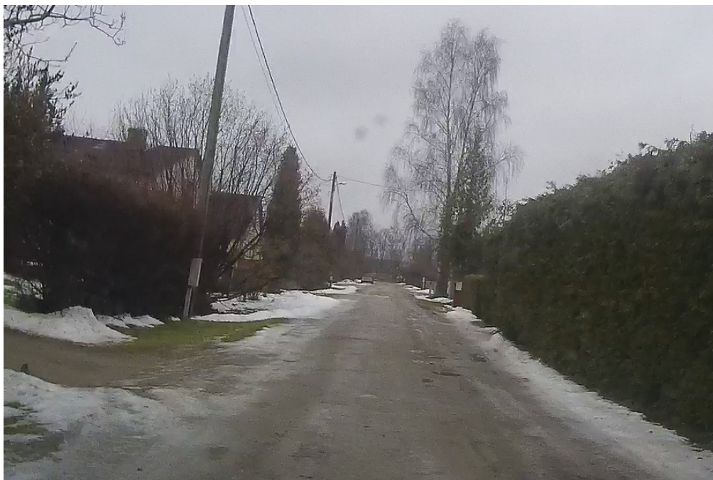
7.attēls. Skats uz trases vidu. Segumā izveidojušās bedres. Segumam nav nodrošināts pietiekams šķērskritums, tādējādi ir kavēta ūdens atvade no brauktuves un veidojas peļķes.
