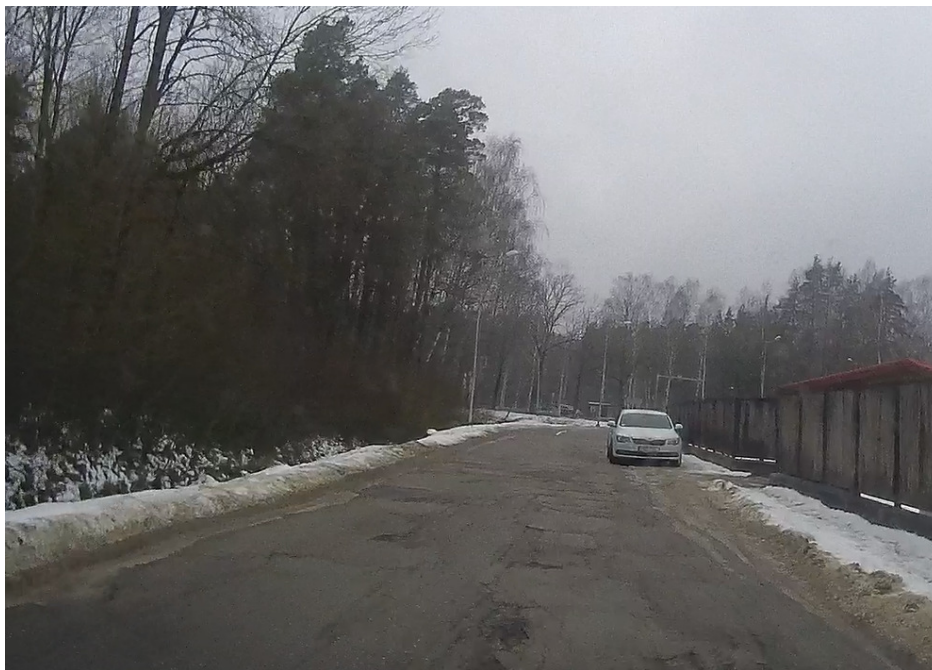
2.attēls. Skats uz trases sākumu, ielas asfaltbetona segums ir sabrucis, izveidojies plašs plaisu tīkls
