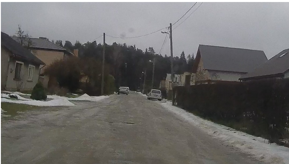
8.attēls. Skats uz trases beigām. Segumā izveidojušās bedres. Segumam nav nodrošināts pietiekams šķērskritums, tādējādi ir kavēta ūdens atvade no brauktuves un veidojas peļķes.
