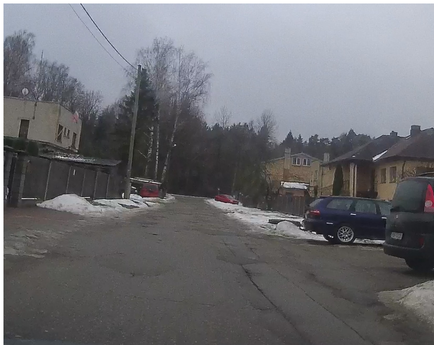
4.attēls. Skats uz trases sākumu, ielas segumā izveidojušās plaisas un iesēdumi
