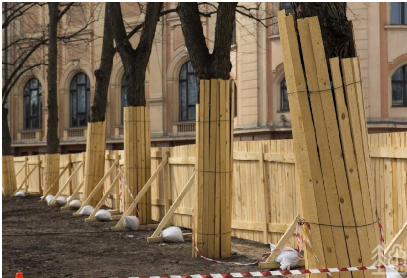
2.attēls. Piemērs koku aizsardzībai būvdarbu laikā
